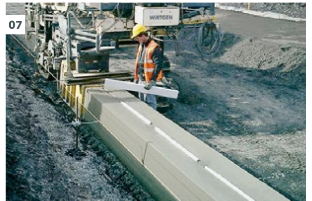
01 对于结构特殊、安全性更高的桥面防护墙：可使用摊铺机在机身右侧摊铺连续配筋的混凝土安全防护墙。 02 ...或从机身左侧摊铺。 03 采用模块化、伸缩式滑模摊铺机摊铺宽达 1.8 m 的人行道和自行车道。 04 - 05 摊铺大型和小型排水沟。 06 采用维特根Auto Pilot 2.0 自动导航系统，精确摊铺各种形状和尺寸的路缘石等整体结构物。 07 滑模摊铺缝隙式水沟，保证排水畅通。
