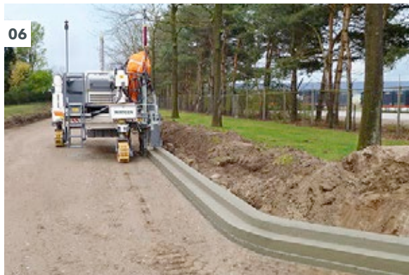
01 对于结构特殊、安全性更高的桥面防护墙：可使用摊铺机在机身右侧摊铺连续配筋的混凝土安全防护墙。 02 ...或从机身左侧摊铺。 03 采用模块化、伸缩式滑模摊铺机摊铺宽达 1.8 m 的人行道和自行车道。 04 - 05 摊铺大型和小型排水沟。 06 采用维特根Auto Pilot 2.0 自动导航系统，精确摊铺各种形状和尺寸的路缘石等整体结构物。 07 滑模摊铺缝隙式水沟，保证排水畅通。
