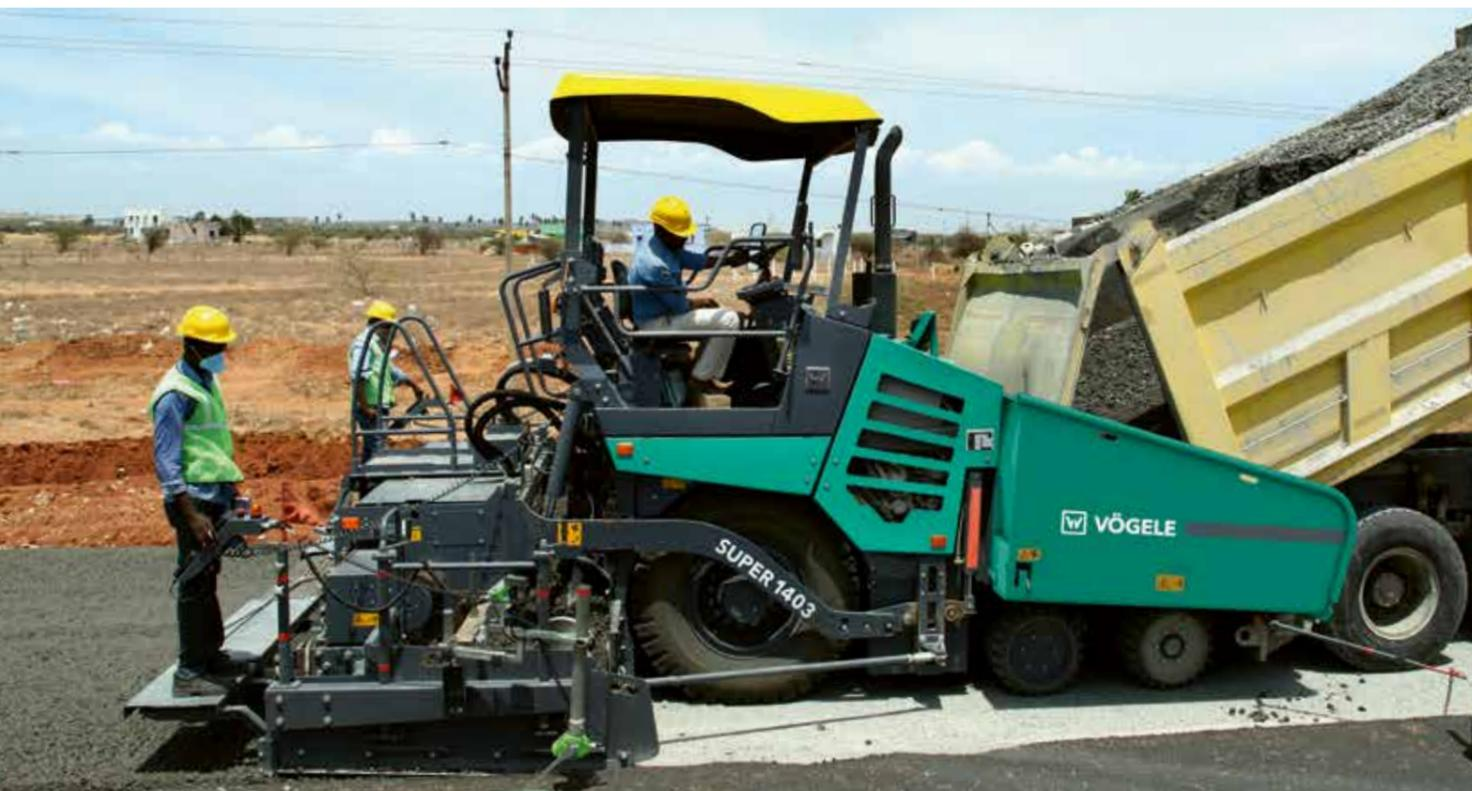
Graças à distribuição perfeita de mistura, a SUPER 1403 garante uma quantidade de material ideal em frente à mesa em todas as situações de pavimentação. Motores hidráulicos potentes e independentes para transportadores e caracóis são instalados e podem atingir altas taxas de distribuição de até 600 t/h.
