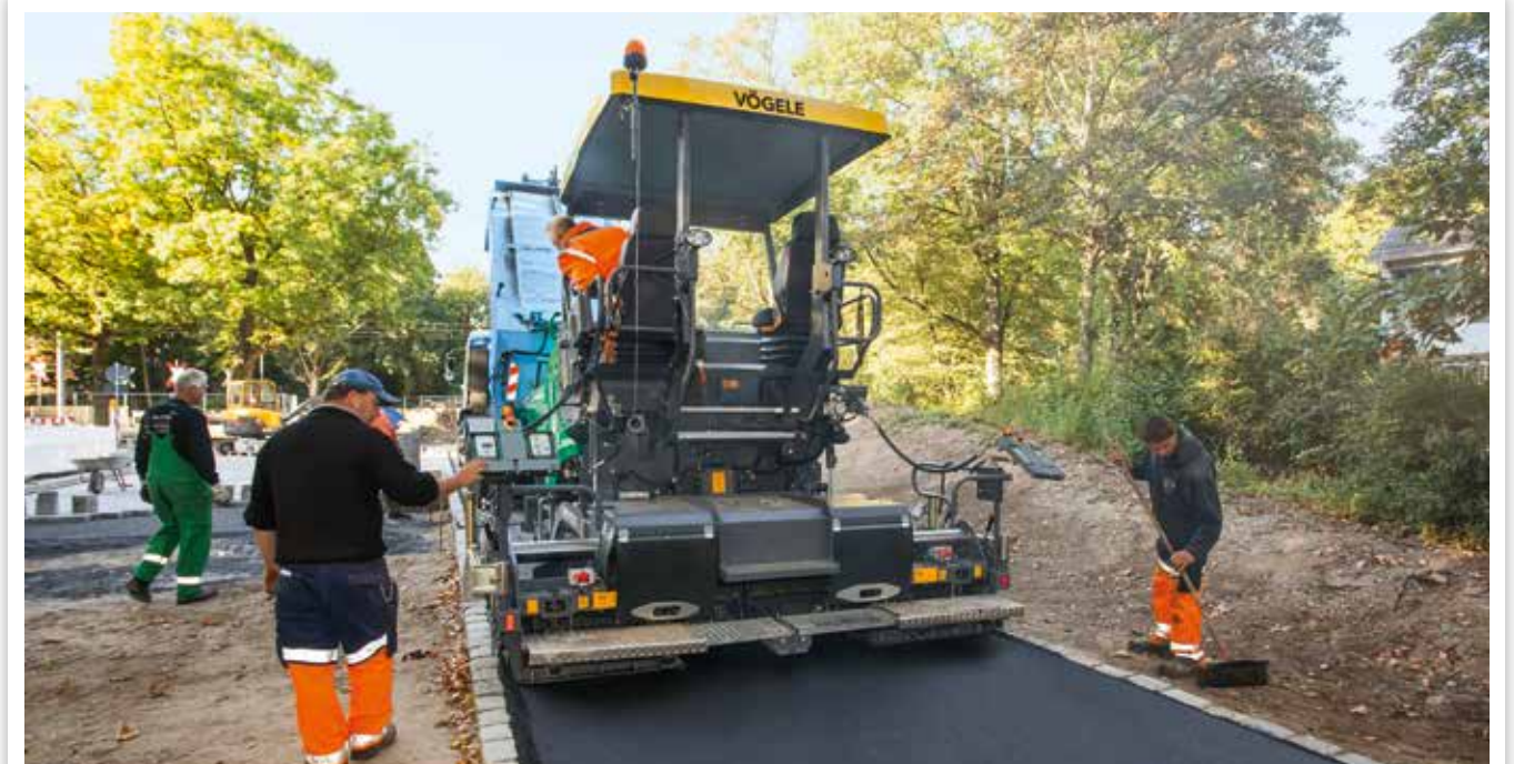
CONSTRUCCIÓN DE CAMINOS EN PARQUES
