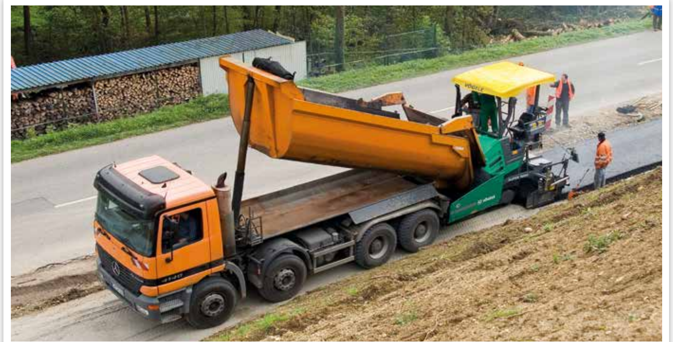
EXTENDIDO DE ASFALTO EN COMBINACIONES DE VÍAS PEATONALES Y CARRILES BICI
