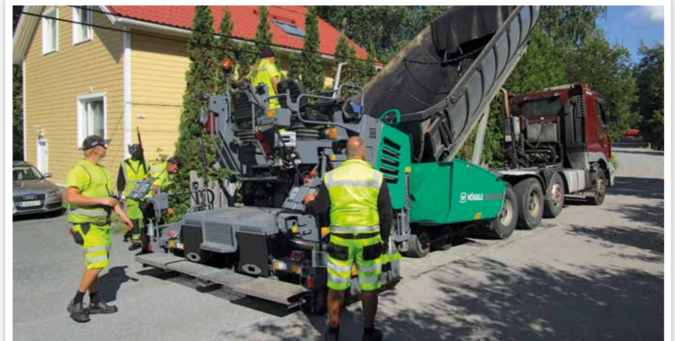
REHABILITACIÓN DE CARRETERAS MUNICIPALES
