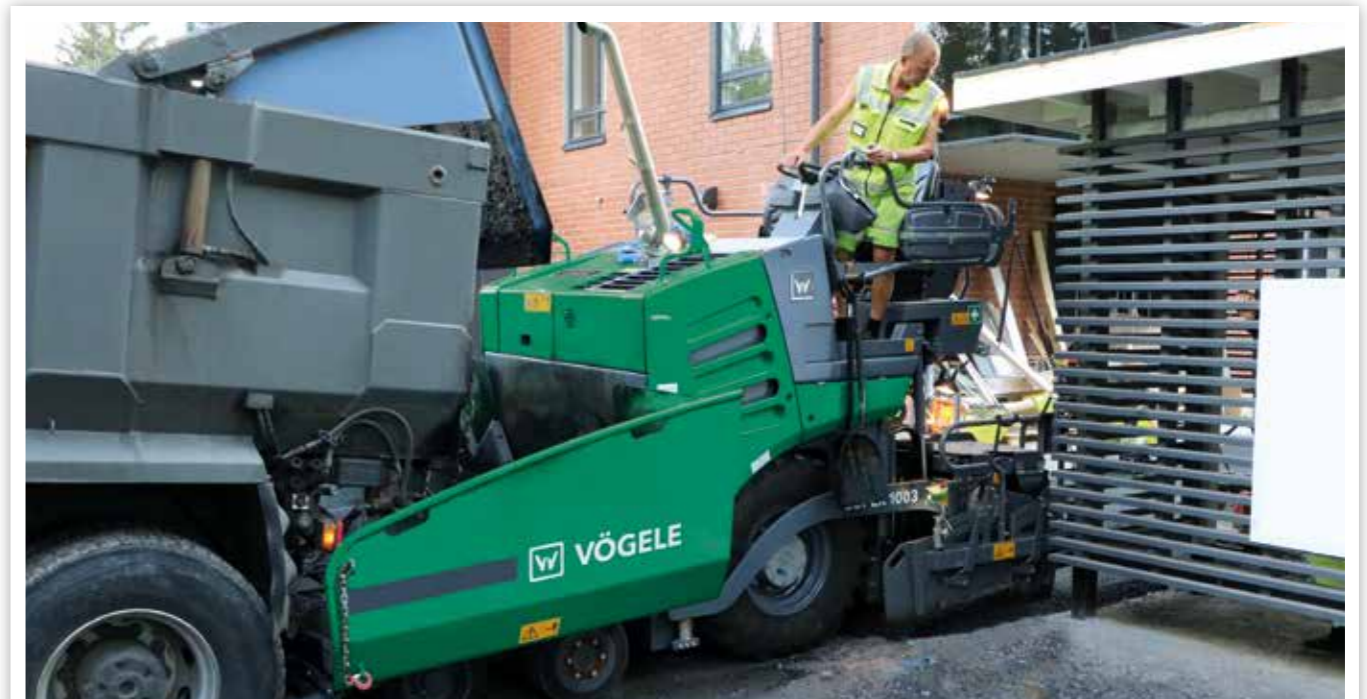
REHABILITACIÓN DE VÍAS DE ACCESO
