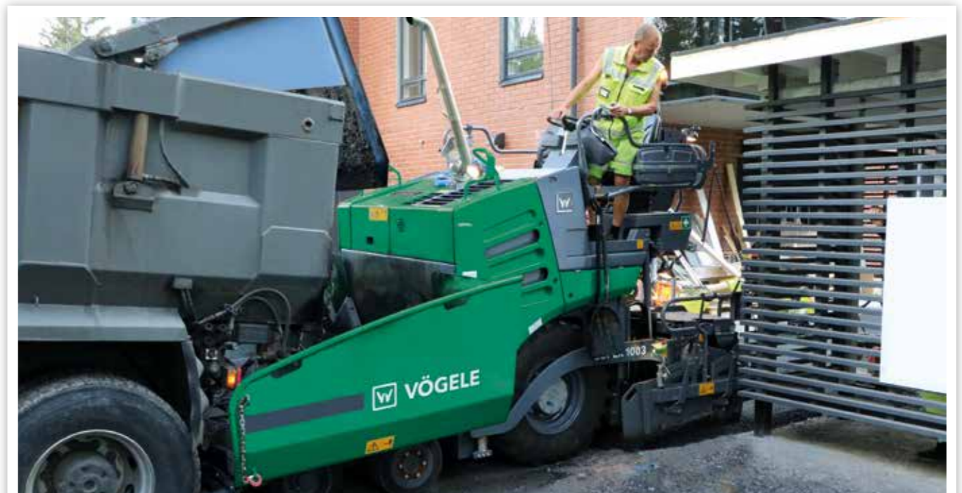
RÉFÉCTION DE VOIES D'ACCÈS
