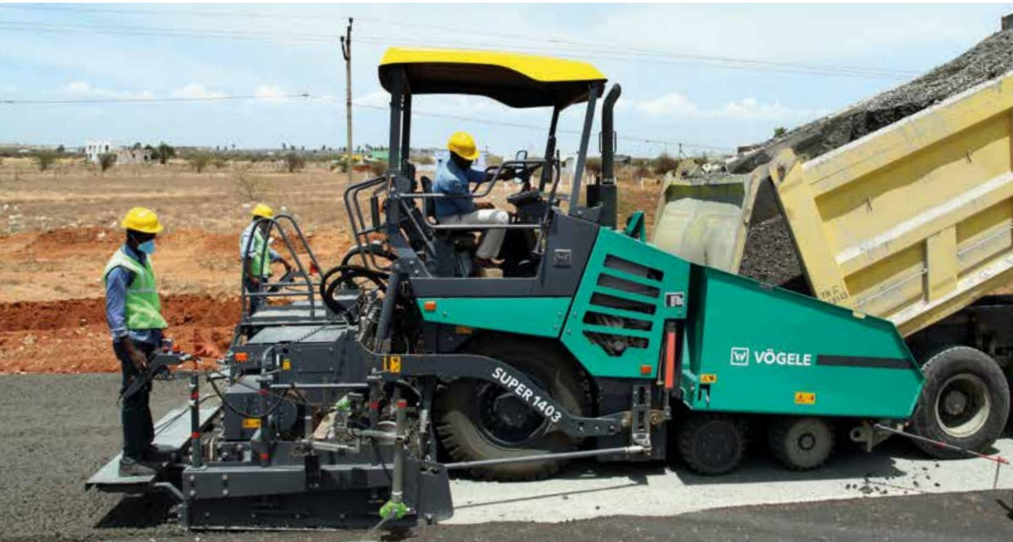
Grâce à un parfait répartition de l'enrobé, le SUPER 1403 offre une réserve de matériau optimale devant la table, quelle que soit la situation de pose. Des entraînements hydrauliques individuels puissants pour les groupes de convoyement permettent d'atteindre des rendements de pose élevés jusqu'à 600 t/h.
