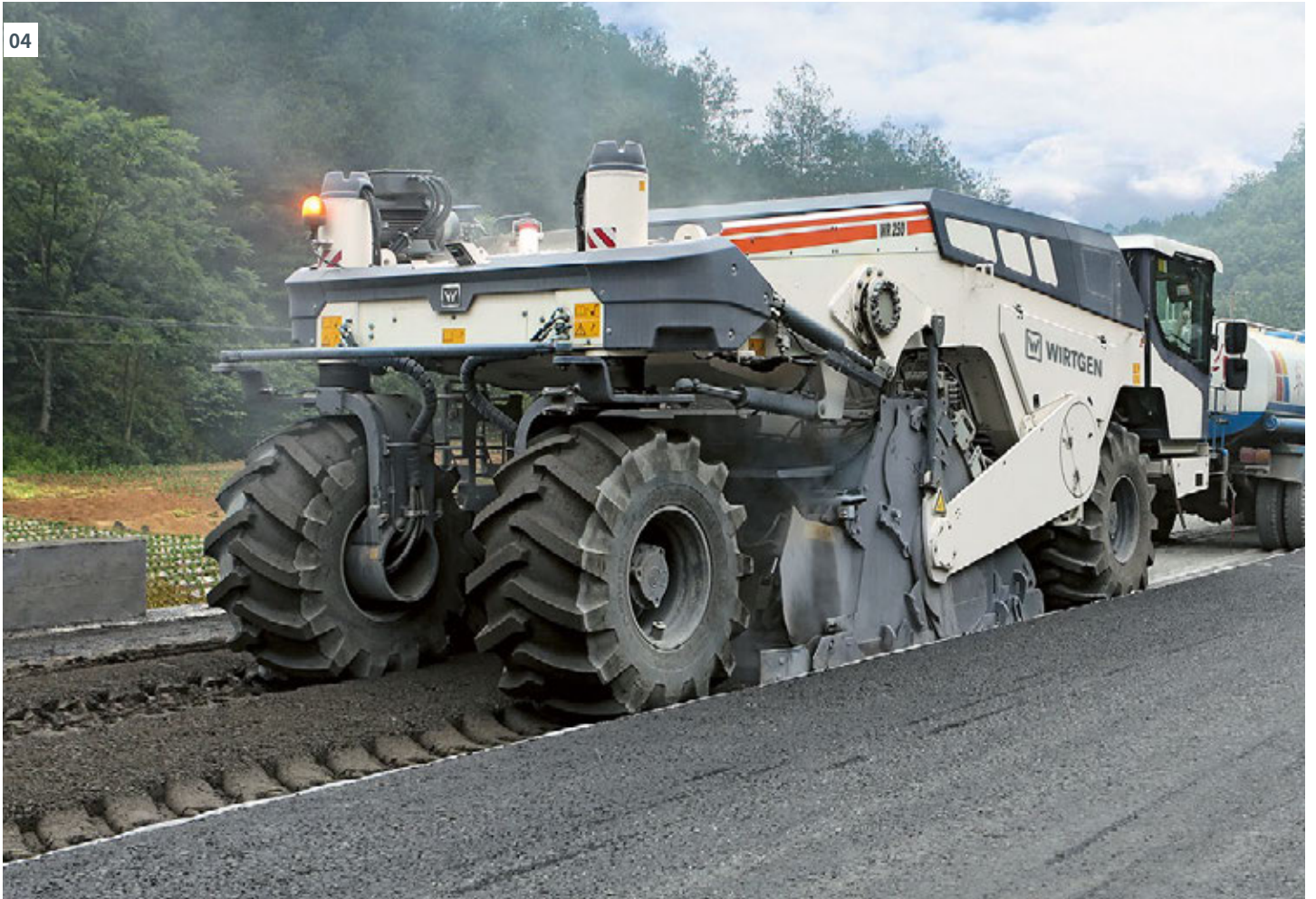
01 - 04 冷再生施工中，强劲的铣刨和拌合转子铣刨受损路面。破碎后的材料与喷入的粘结剂高效拌合，生成均匀的再生混合料，直接用于摊铺和压实。
