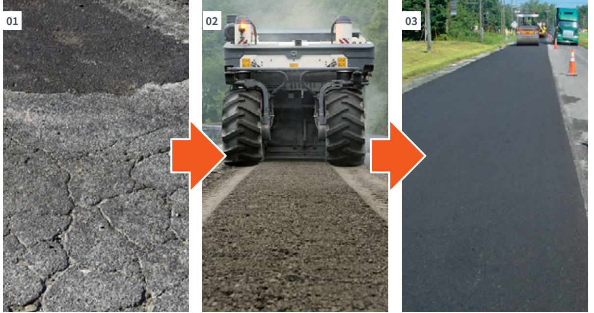
01 - 04 冷再生施工中，强劲的铣刨和拌合转子铣刨受损路面。破碎后的材料与喷入的粘结剂高效拌合，生成均匀的再生混合料，直接用于摊铺和压实。
