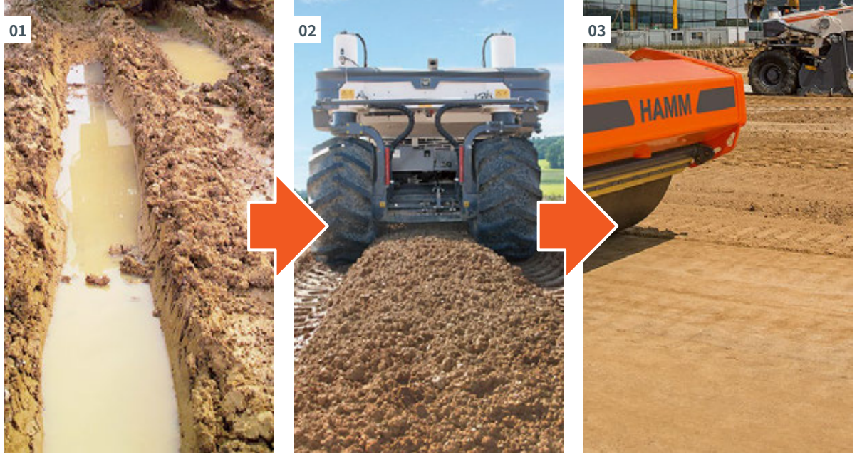
01 - 04 土壤稳定施工, 能够将承载力不足的土壤就地转换为优质的筑路材料, 直接用于摊铺和压实。
