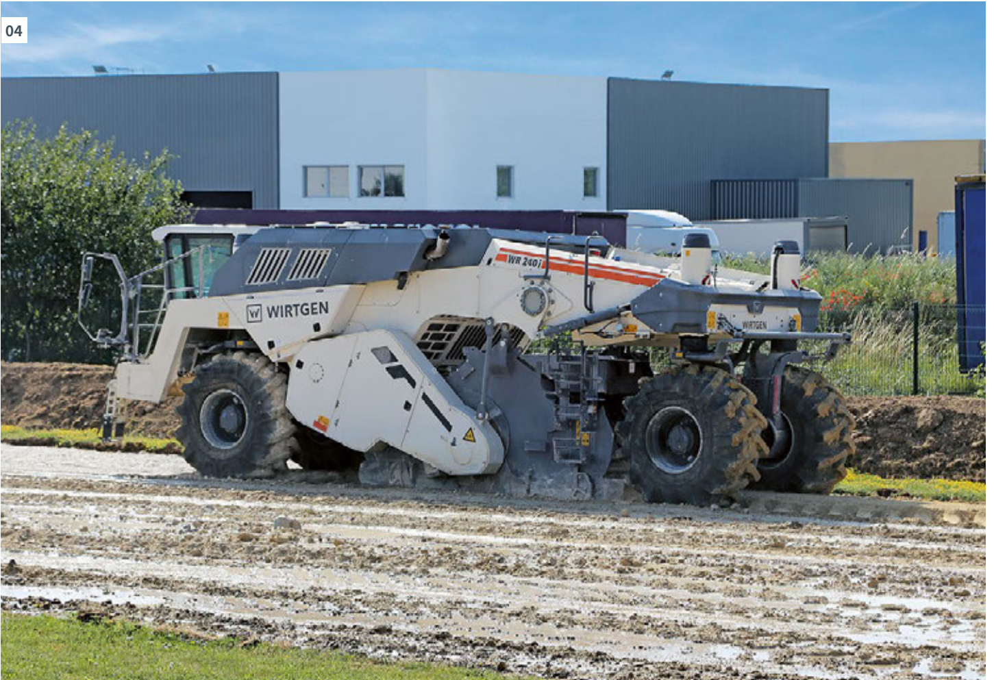
01 - 04 土壤稳定施工, 能够将承载力不足的土壤就地转换为优质的筑路材料, 直接用于摊铺和压实。
