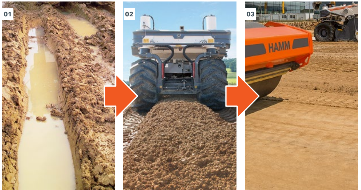
01 - 04 Bei der Bodenstabilisierung wird ungenügend tragfähiger Untergrund in gut einbaufähigen und verdichtbaren Boden verwandelt.
