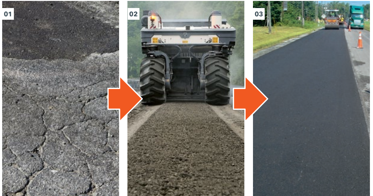
01 - 04 Beim Kaltrecycling werden beschädigte Asphaltsschichten granuliert, mit Bindemittel vermischt aufbereitet, verdichtet und wieder eingebaut.
