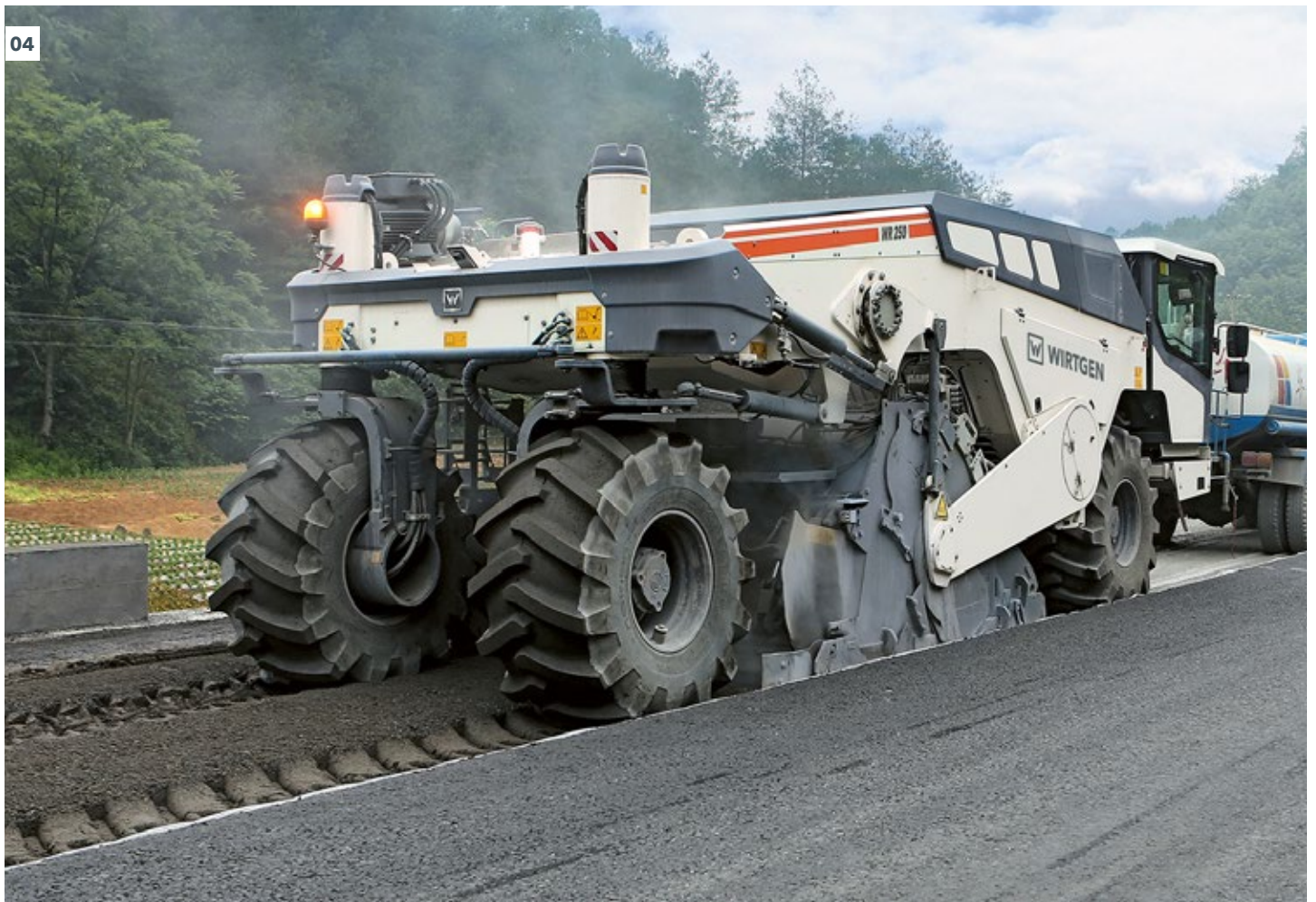
01 - 04 Beim Kaltrecycling werden beschädigte Asphaltsschichten granuliert, mit Bindemittel vermischt aufbereitet, verdichtet und wieder eingebaut.
